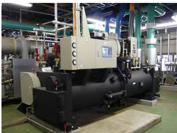
電気式ターボ冷凍機
