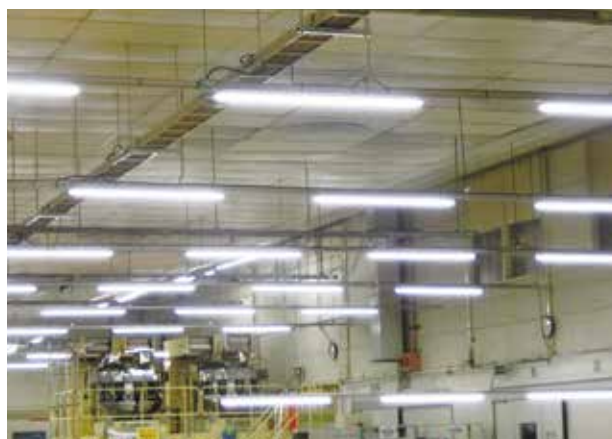
更新したLED照明(秦野工場)
