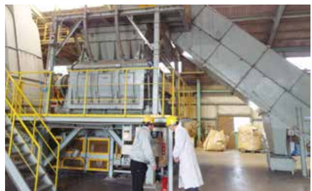
処理施設の現地確認の様子
