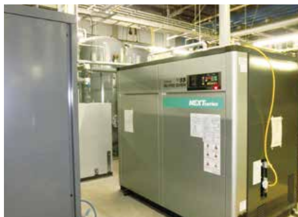
更新したコンプレッサー(秦野工場)
