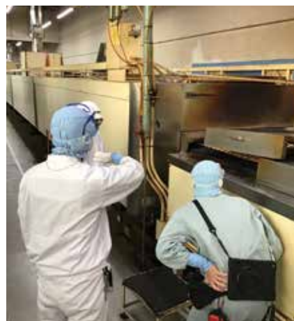
オープン防火点検の様子
