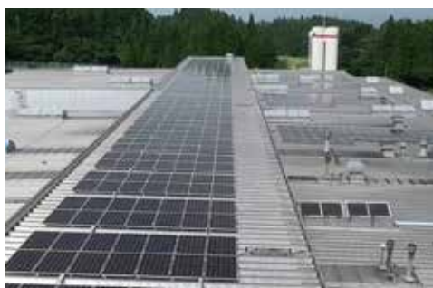
設置した様子
