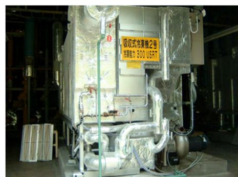
省エネタイプ吸収式冷凍機への変更 (湘南工場 富士裾野)
