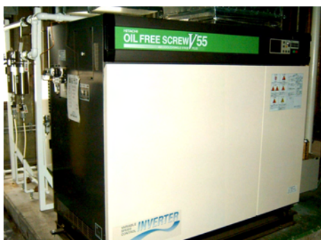
コンプレッサーのインバーター化 (湘南工場 平塚)
